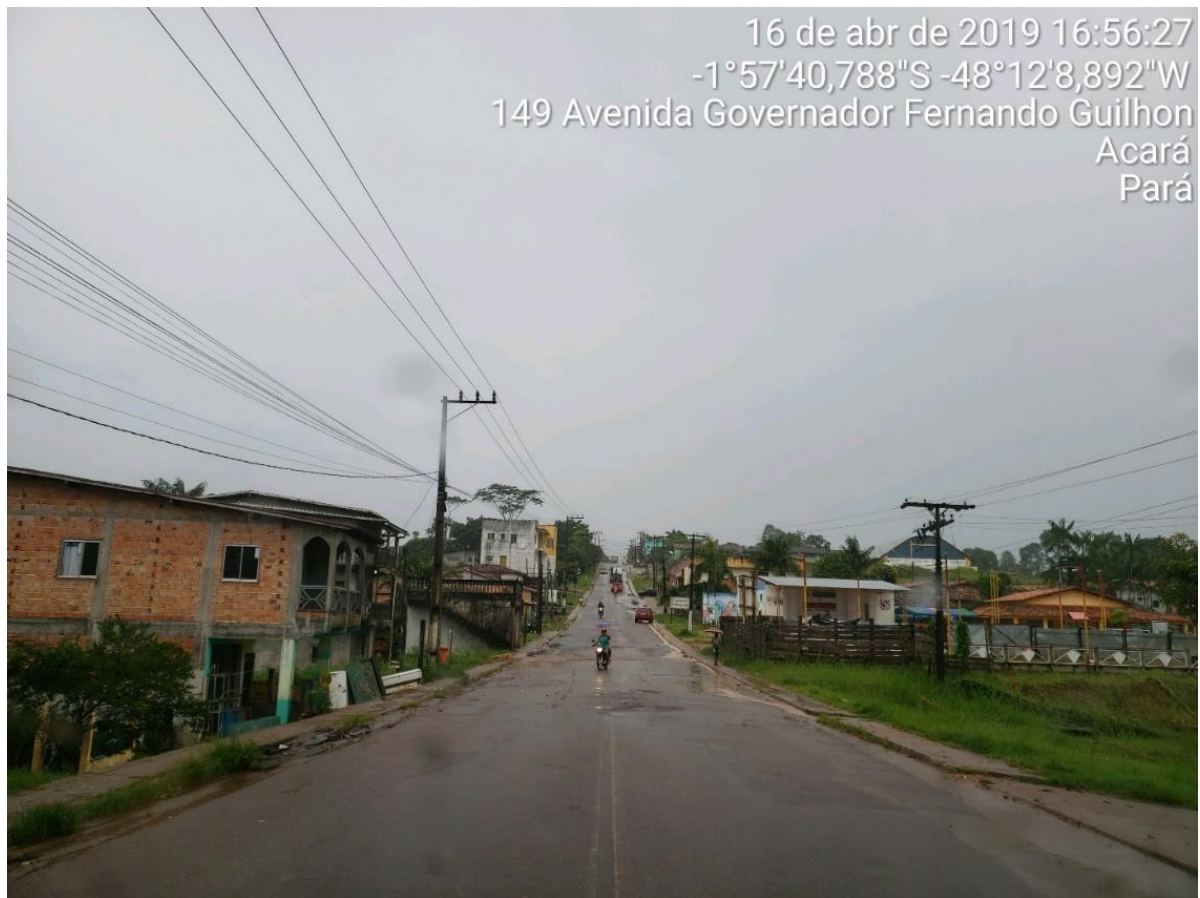
Figura 19 – Trecho urbano da rodovia PA-252, cidade do Acará
